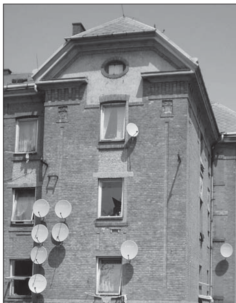
Ulice Železná č. 12.
